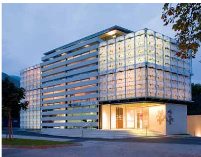
Beweglicher Sonnenschutz und Versteck für die Zahl der Stockwerke: Die Lamellenfassade aus PLEXIGLAS SATINICE® im österreichischen Hall verbindet ein historisches und modernes Viertel.
