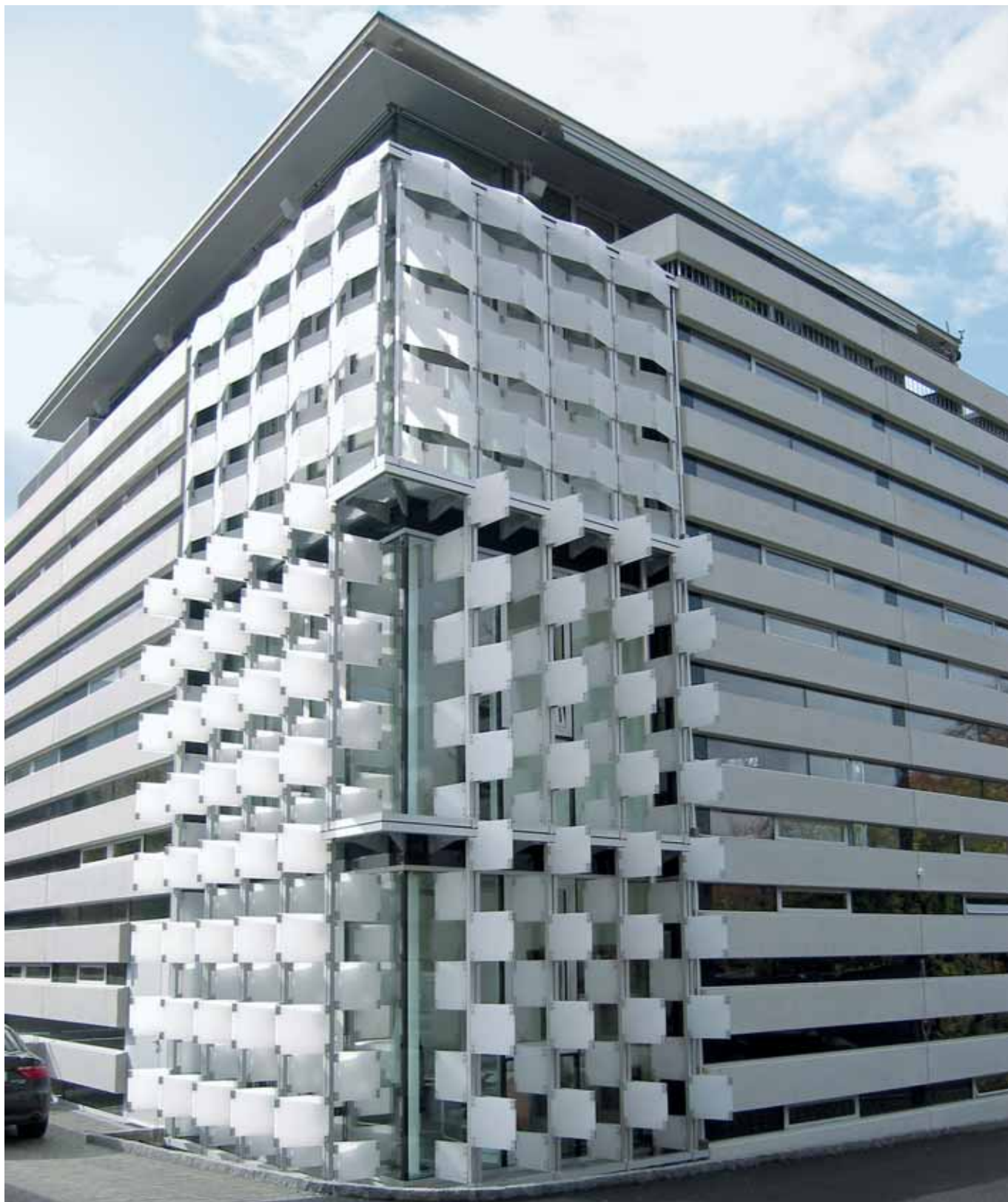
Beweglicher Sonnenschutz und Versteck für die Zahl der Stockwerke: Die Lamellenfassade aus PLEXIGLAS SATINICE® im österreichischen Hall verbindet ein historisches und modernes Viertel.
