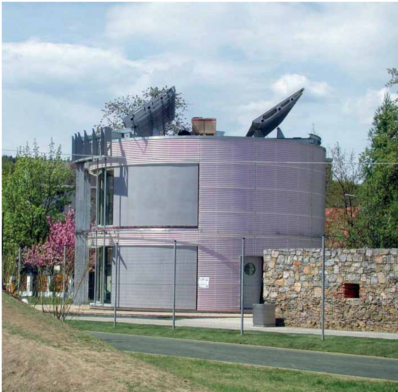
Der Sonne entgegen, und das mit eigener Energie: Seit über zehn Jahren produziert das Haus mit Solarwabenfassade aus PLEXIGLAS® seine Energie selbst. Damit die Sonneneinstrahlung immer optimal ist, dreht sich das Plusenergiehaus im Laufe eines Tages um 180 Grad.
