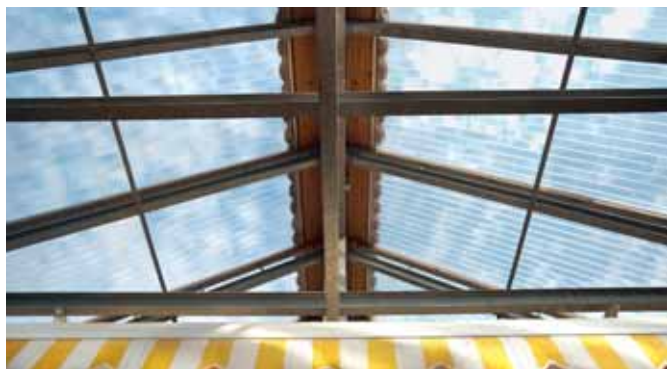
Lastre alveolari trasparenti garantiscono il positivo effetto serra.
