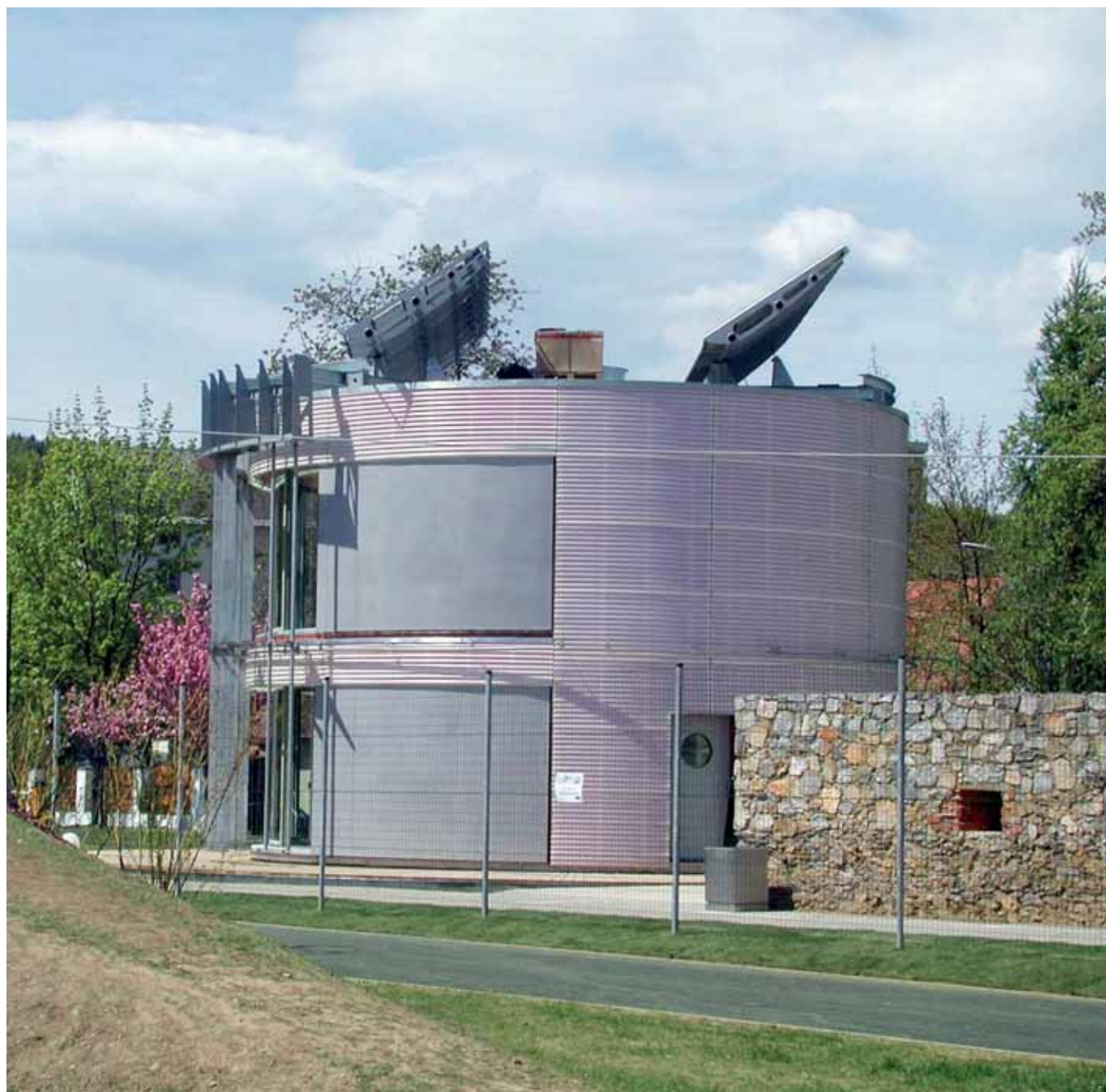
À la rencontre du soleil, et cela de sa propre énergie : depuis plus de dix ans, la maison produit elle-même son énergie grâce à sa façade solaire en nid d'abeille intégrant du PLEXIGLAS(R). Pour optimiser le rayonnement solaire, la maison à économie d'énergie pivote de 180 degrés au fil de la journée.
