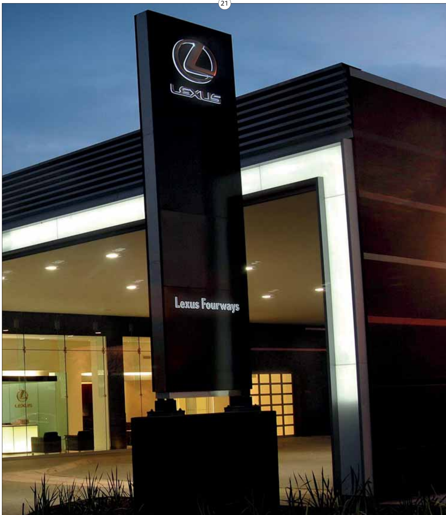
Les concessions sud-africaines de Lexus brillent sous le feu des grands panneaux lumineux en PLEXIGLAS truLED® associés aux DEL – à moindres frais, et en permettant même des économies d'énergie.
