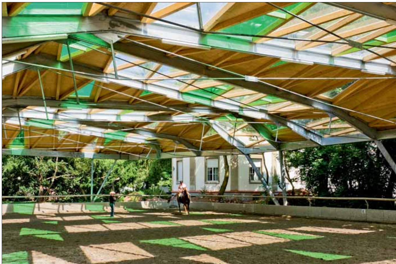
Verdi lastre di PLEXIGLAS® trasformano la sabbia del maneggio del Politecnico di Darmstadt in un prato verde
